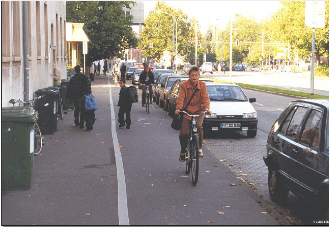
baulicher Radweg zwischen Gehweg und Parkstreifen / Kfz-Fahrstreifen
