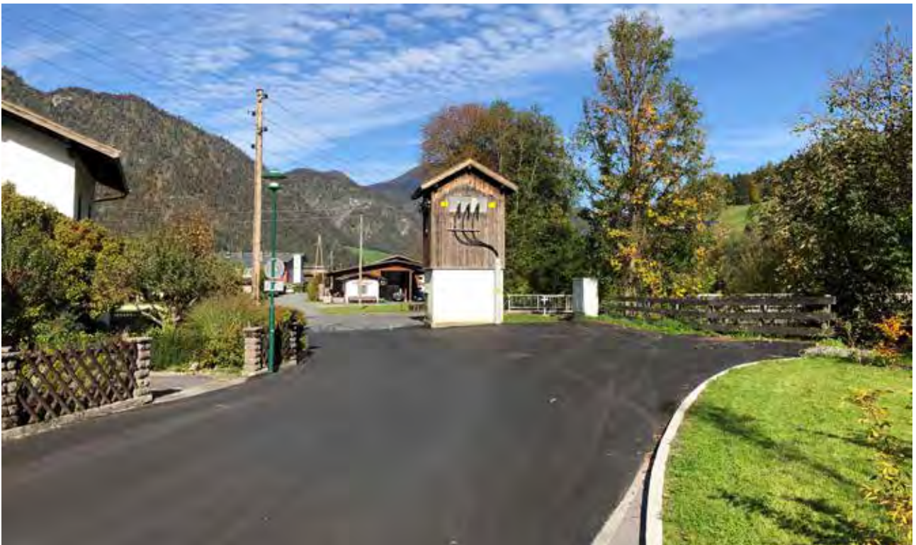
Asphaltierte PKW-Stellplätze welche den Fußweg unterbrechen
