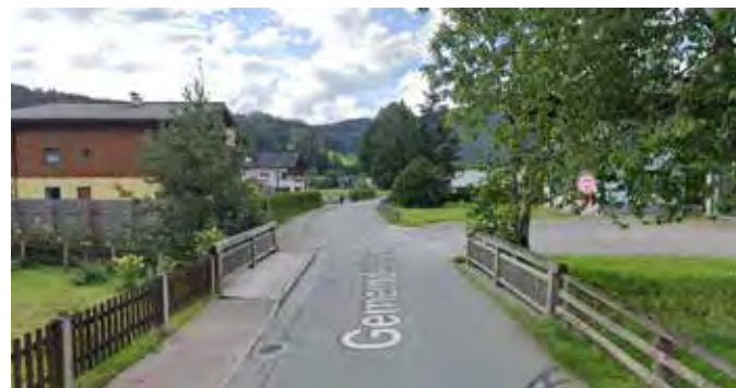
Maßnahme 1.6) Neubau Klemmbachbrücke
