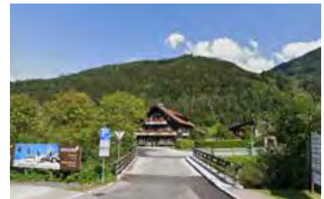
Maßnahme 3.7) Aufwertung Fuß- und Radverbindung durch Aufwertung der Brücke zur BGZ Spar
